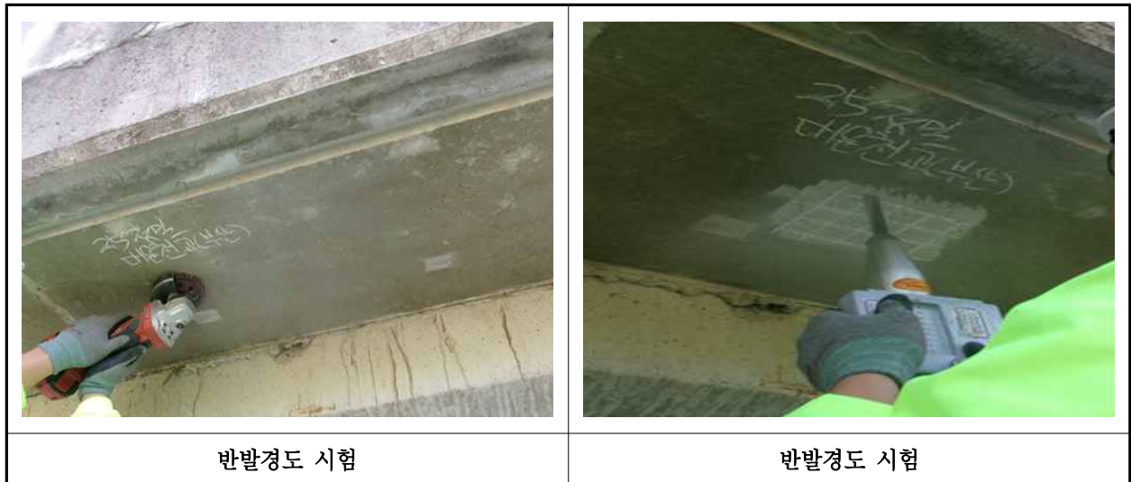
【사진 15.4.2】 반발경도시험 현장사진
