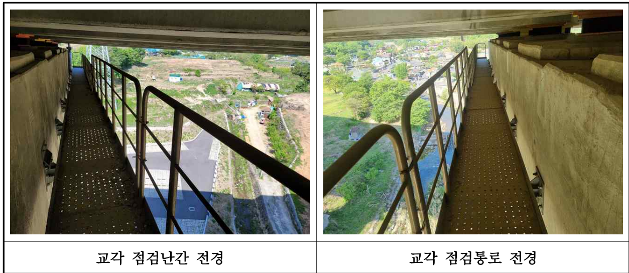
【사진 15.3.26】 교량 점검시설 전경
