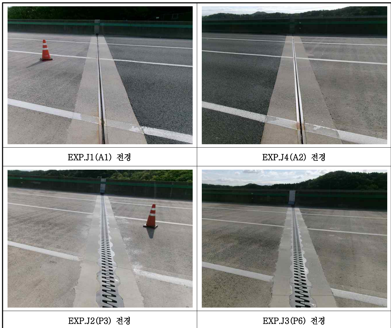
【사진 15.3.17】 신축이음장치 전경
