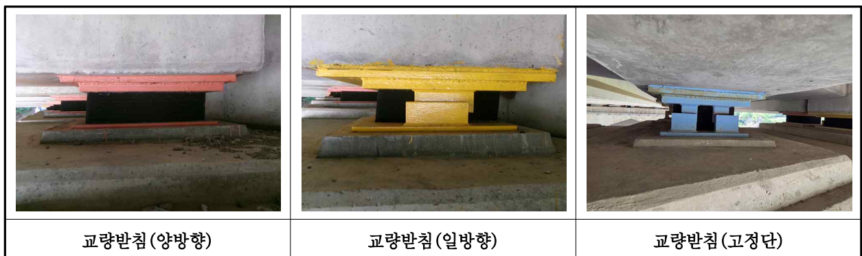
【사진 15.3.13】 교량받침 전경
