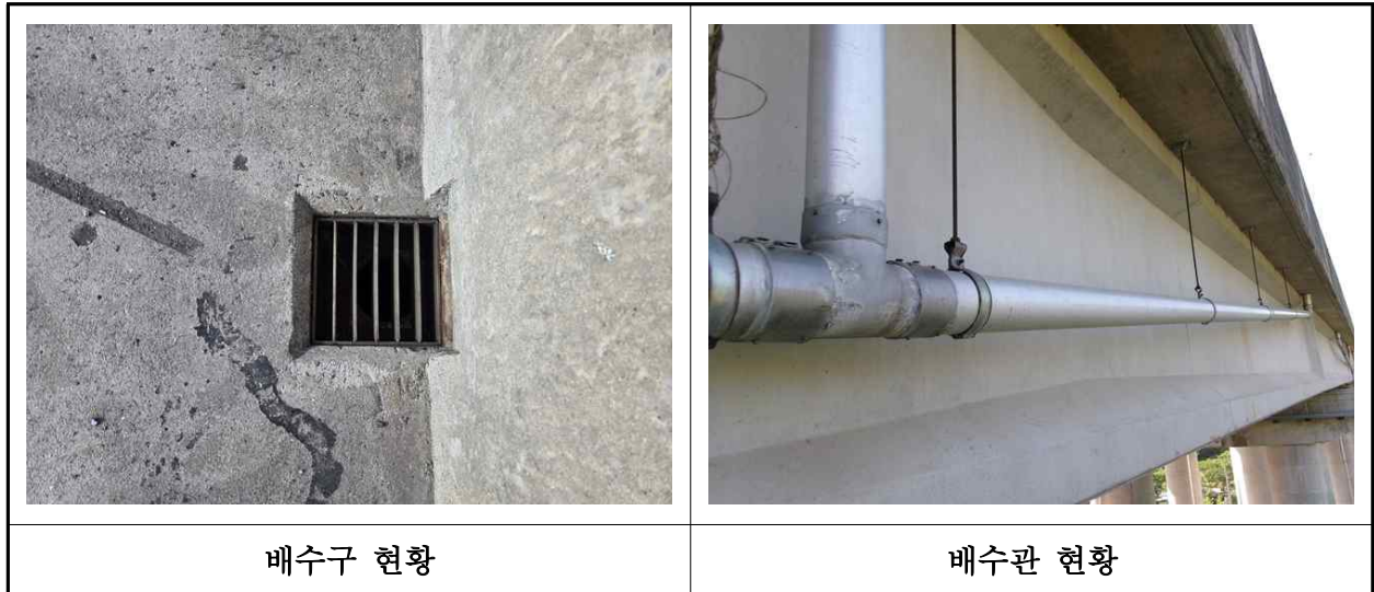
【사진 15.3.22】 배수시설 전경
