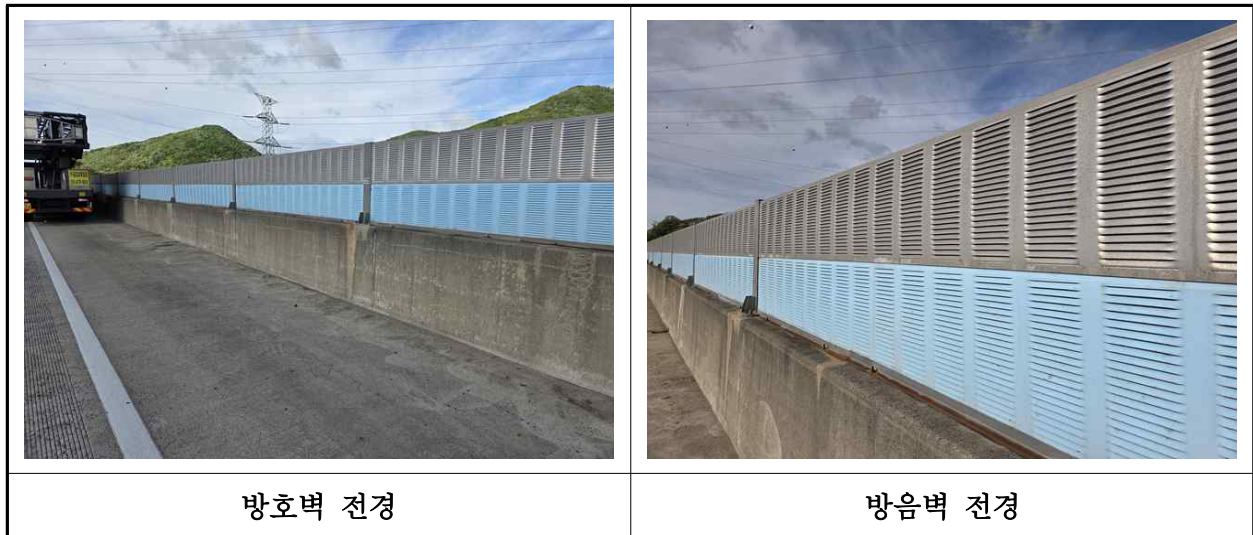
【사진 15.3.24】 방호벽 및 중분대 전경
