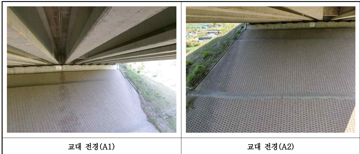
【사진 15.3.8】 교대 전경
