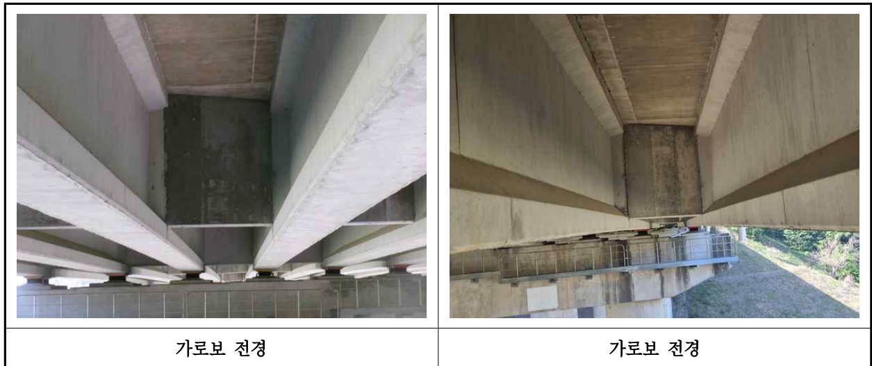
【사진 15.3.6】 가로보 전경
