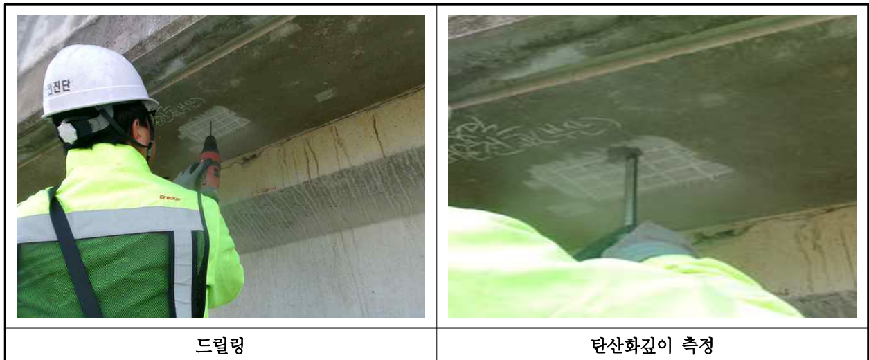
【사진 15.4.3】 탄산화 깊이 측정 현장사진
