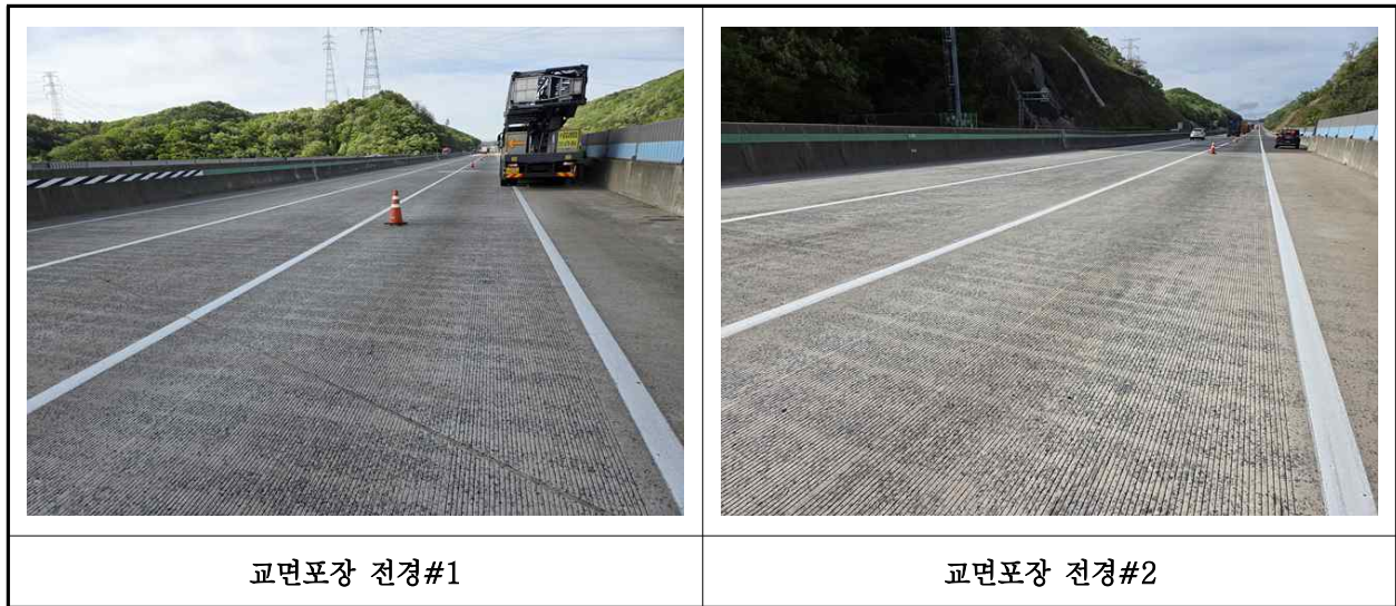
【사진 15.3.20】 교면포장 전경
